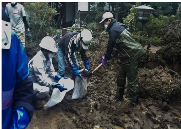
土嚢袋を使って庭の泥を搬出する国際本部の支援チーム
