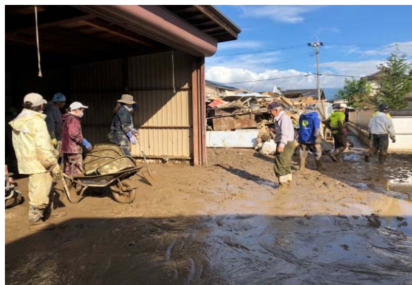
千曲川の氾濫に伴い、宅地に浸入した汚泥の搬出作業に取り組む
