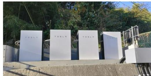
リチウムイオン蓄電池（135kWh）を設置
