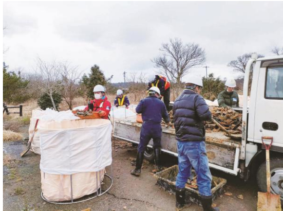
トラックから瓦を降ろす作業
